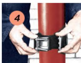
4 Разместите стальную пластину поверх уплотнительной прокладки.
