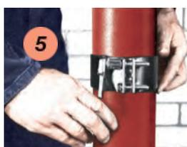
5 Поочередно и равномерно затяните оба зажимных винта. Во избежание возможной деформации направляющие пластины и пластины с резьбовыми отверстиями должны быть совмещены параллельно.
