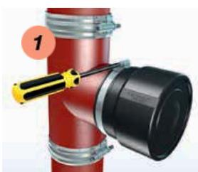
Ослабить червячный хомут, надеть соединитель FIX / CONFIX-MULTI на чугунную трубу и затянуть червячный хомут.
